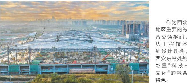
作为西北地区重要的综合交通枢纽,从工程技术到设计理念,西安东站处处彰显“科技+文化”的融合特色。
