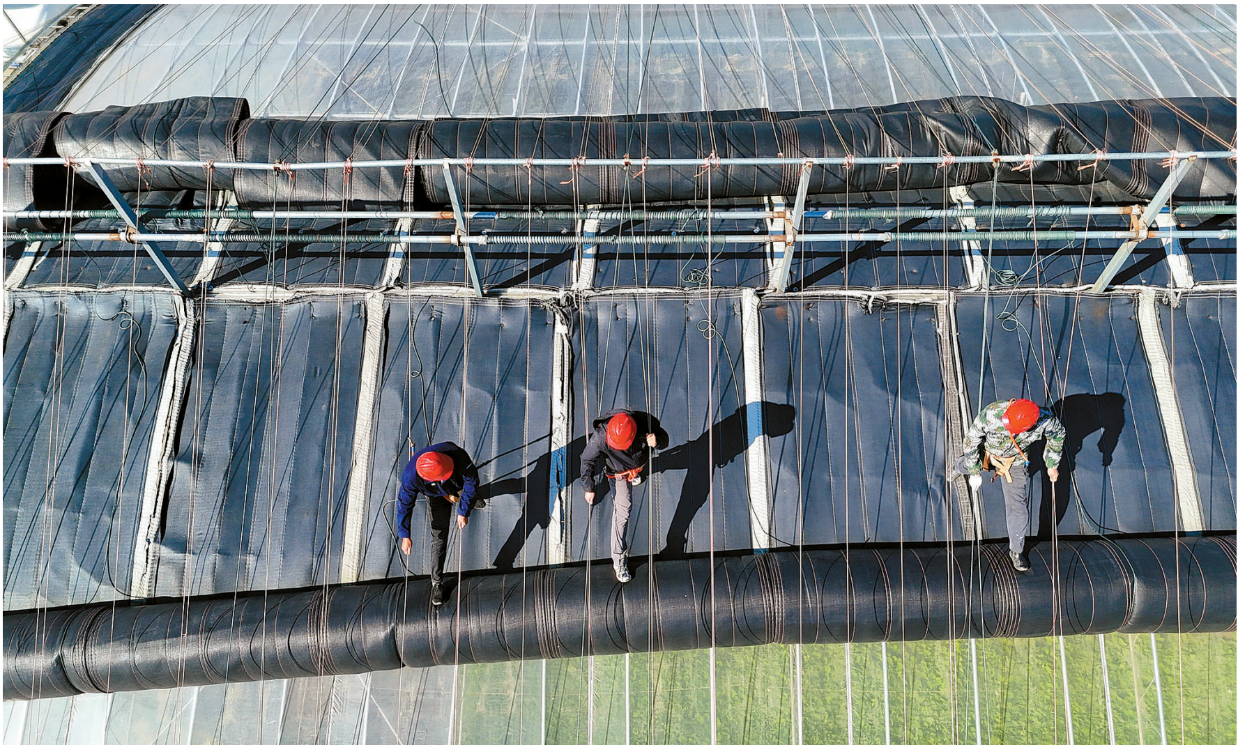
10月23日，江苏连云港，工作人员对高效农业示范园的温室大棚进行维修保养，调试保温棉被、电机线路等基础设施，确保降温期间大棚作物的正常生长。
