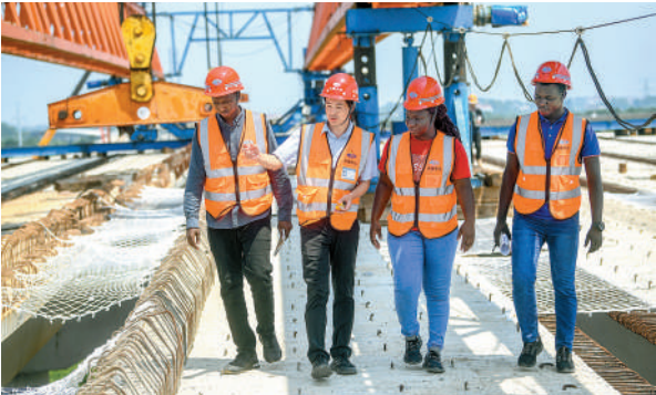
2022年7月27日，武汉，武汉大学的3名非洲留学生在黄陂的一段高速公路施工工地实习。
