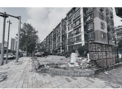
天津市柳林街道龙博花园小区围裙修缮前后对比图(上图为修缮后)
