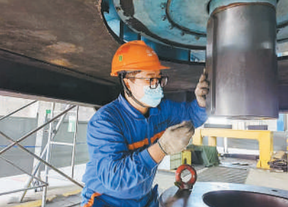
张成亮正在进行核电站海水循环泵检修工作。受访者供图
