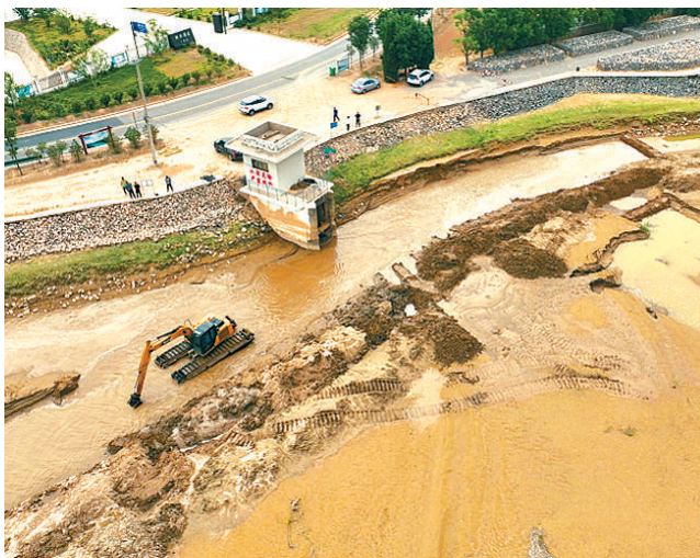
山西大禹渡灌区新兴水源站挖河保供。
