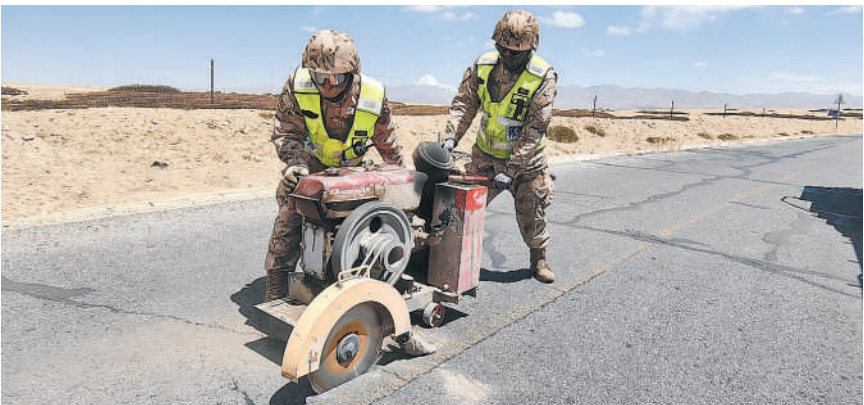
救助站官兵在马攸木拉对道路裂缝进行切割修补。
