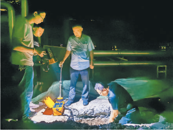
徐丙垠(右二)带着学生连夜查找电缆故障原因。
