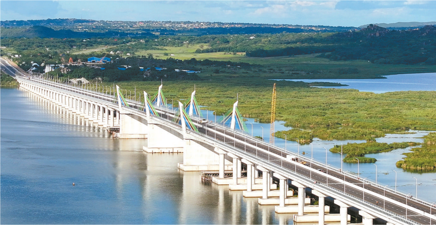
马古富力大桥是第一座跨越维多利亚湖的永久性桥梁，也是非洲最长的矮塔斜拉桥。
