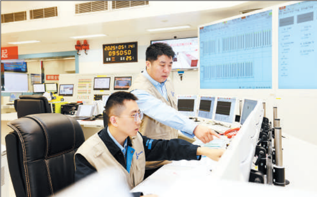
5月14日，“华龙一号”全球首堆主控室工作人员在岗位值守。当日，我国自主三代核电“华龙一号”全球首堆——中核集团福清核电5号机组实现连续安全稳定运行1000天，持续向社会稳定输出清洁电力超370亿度。2015年，“华龙一号”全球首堆落户福建福清开工建设。 福建福清核电有限公司供图(新华社发)
