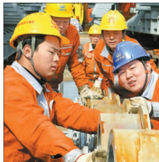
陈汉龙(右一)带领班组技术人员对斜架承重梁轮组进行水平线调试。 潘万齐/摄
