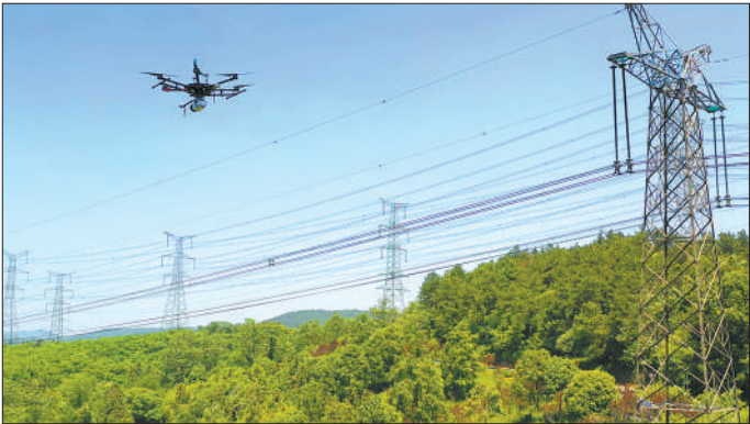
国网江苏电力无人机搭载激光点云设备，对电网线路数据进行采集。
