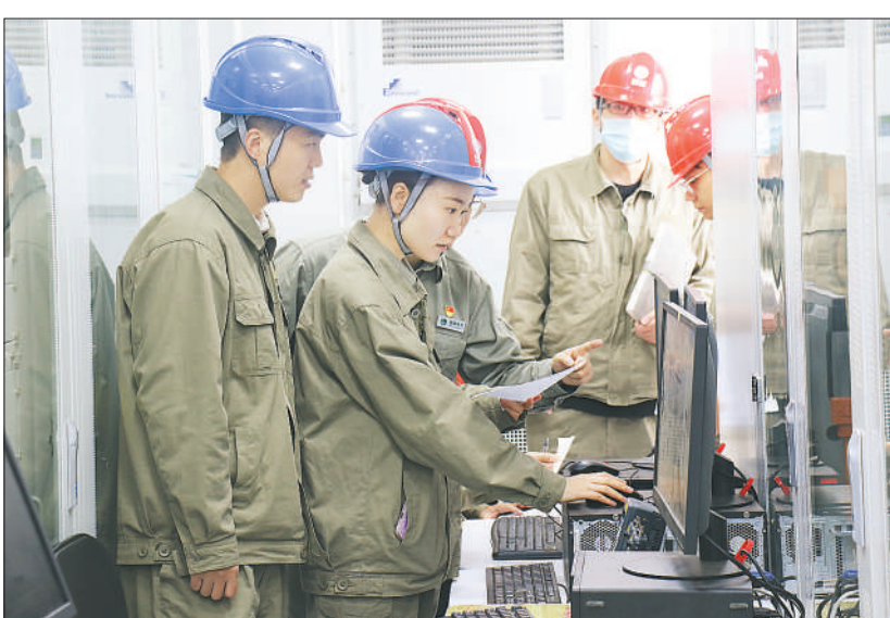
国网湖北省电力有限公司电力科学研究院新型电力系统研究中心团队在随州广水开展新型电力系统现场试验。
