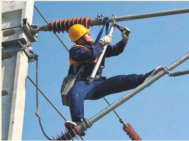
郭增磊正在更换接触网腕臂支撑。
